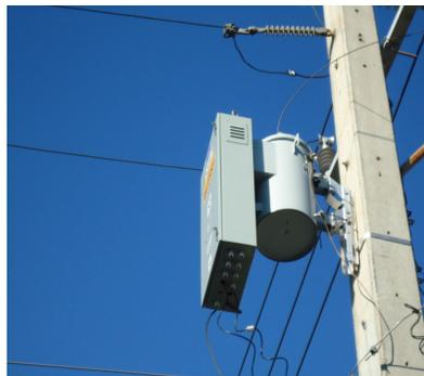
2.-En otros casos se usa conjuntamente con un medidor para prevenir el fraude de energía, ya que controla la corriente total que sale hacia la acometida, detectando si alguien manipulo el medidor o si hay conexiones ilícitas.
